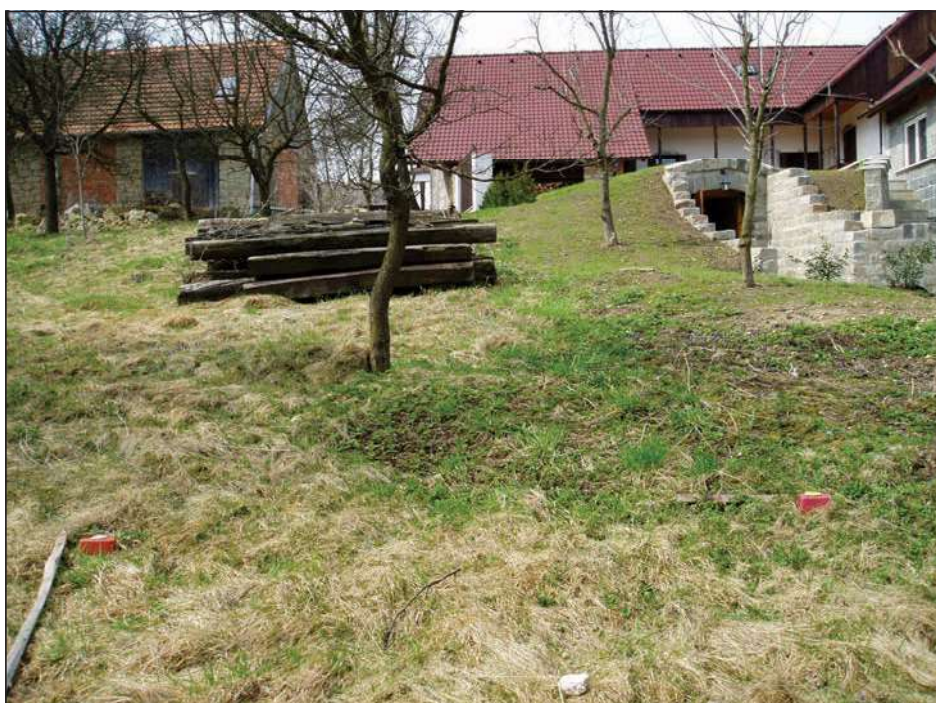
Na snímku je vidět nejednotná stabilizace hranice pozemků
